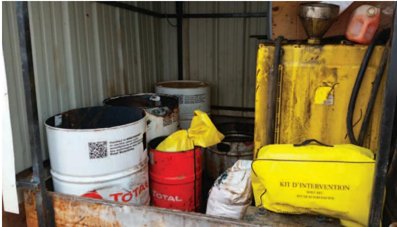
Figure 96 : Exemple d'aire de stockage pour matériaux polluants (Source : Guide technique "Protection des milieux aquatiques en phase chantier", AFB, 2018)
