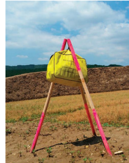
Figure 97 : Exemple d'un kit anti-pollution isolé du sol (Source : Bouygues)
