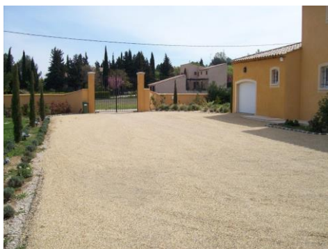
Concassé calcaire carrossable et non carrossable afin de limiter l'utilisation d'enrobé et de bicouche sur les chemins de rondes
