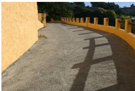
Bicouche carrossable sur les chemins de rondes
